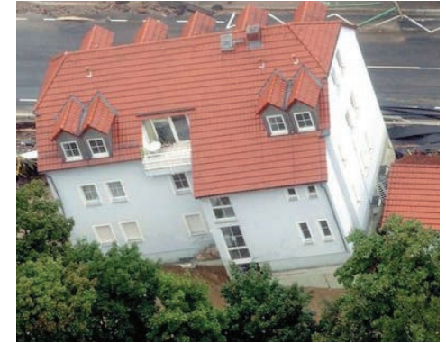
Figure 19 Effondrement d'un bâtiment
