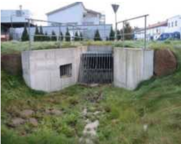
Abbildung 77: Beispiel großzügig dimensioniertes Einlaufbauwerk Quelle: Stadt Karlsruhe
