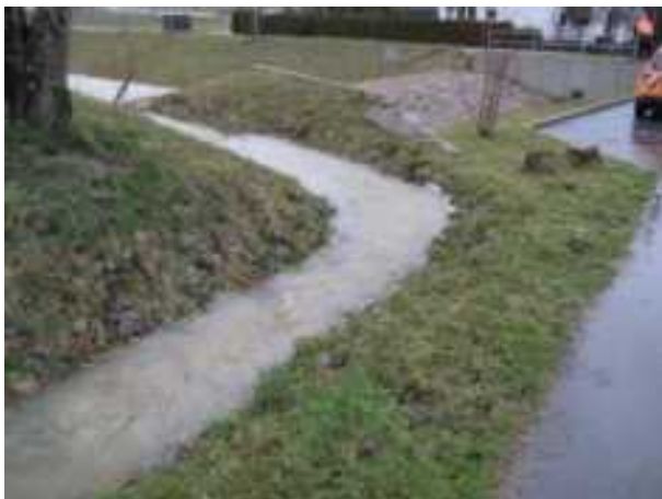
Abbildung 75: Beispiel großzügig dimensionierter Leitgraben Quelle: Wald Corbe
