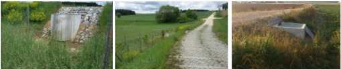
Abbildung 54: Beispielfotos Rückhalteräume durch Erhöhung Feldwege aus PPT Sandra Corbeck 2017, Neue Wege zum Boden- und Gewässerschutz, Bay. Verwaltung für ländliche Entwicklung
