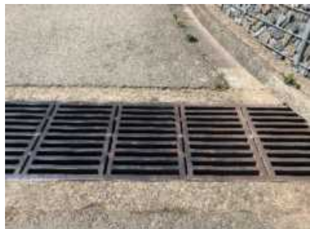
Abbildung 85: Beispiel breite Überfahrbare Entwässerungsrinne mit breiten Schlitzten
