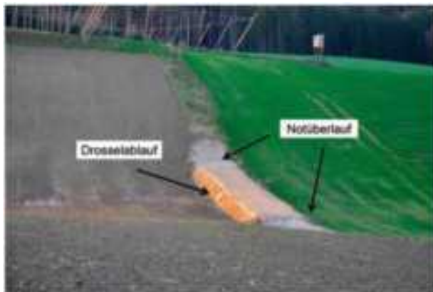
Abbildung 56: Kleinrückhaltebeckens in einer Abflussmulde am Übergang zwischen Acker und Grünland. Abflussdrosselung durch schmales Rohr. Verlegungsschutz erforderlich! , als Notentlastung dienen zwei befestigte Überlaufmulden. Beispielfoto H S Ingenieure Freising,
