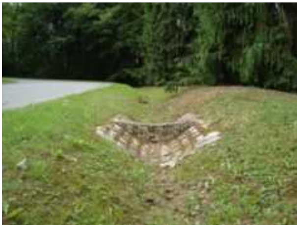
Abbildung 58: Gutes Beispiel Graben mit Querbauwerk zur Optimierung, Archiv eepi
