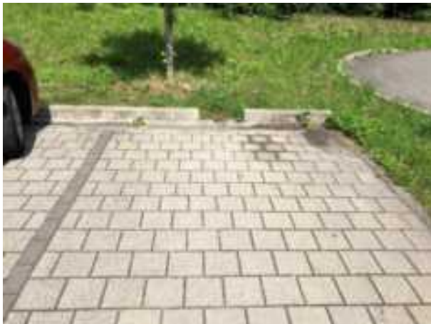
Abbildung 82: Beispiel Ableitung Wasser von Parkflächen in Freiflächen
