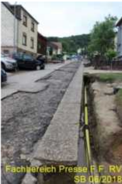
Abbildung 21: Freigespülte Gasleitung
