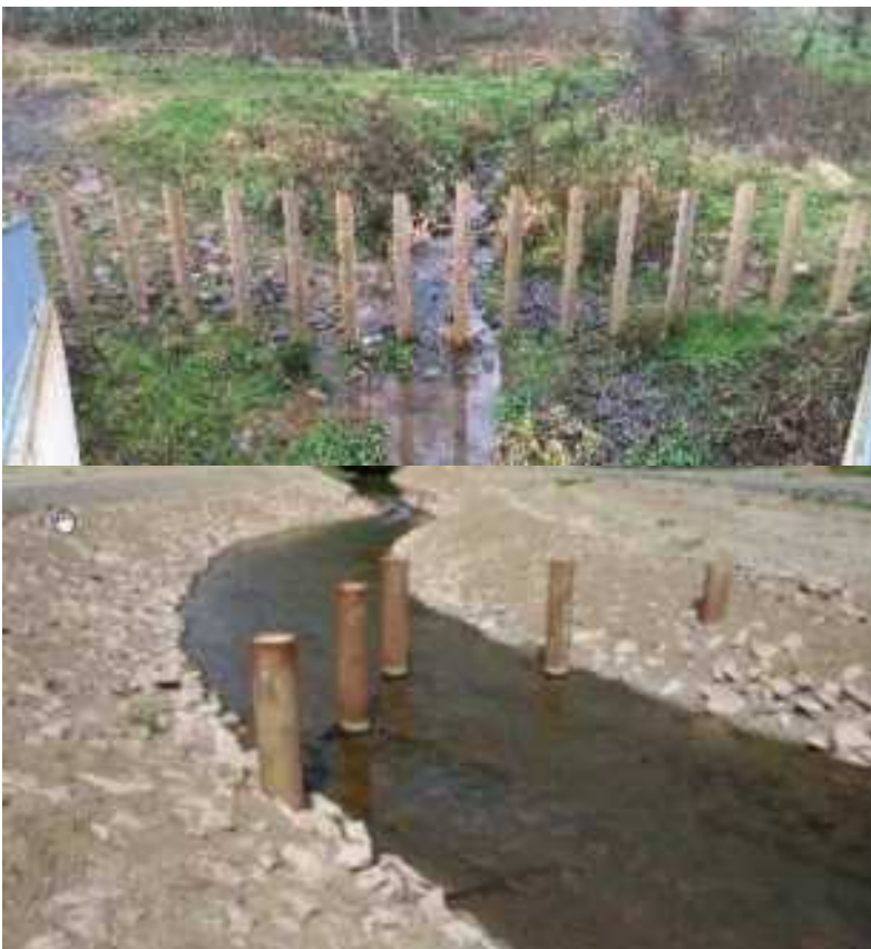
Abbildung 47: Sohlrechen/Treibstoffrückhalt im Sturzflutentstehungsgebiet [17], [18]
