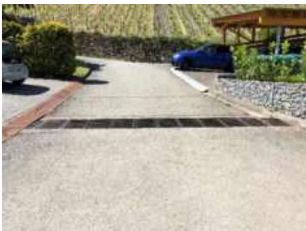
Abbildung 84: Beispiel breite Überfahrbare Entwässerungsrinne mit breiten Schlitzten
